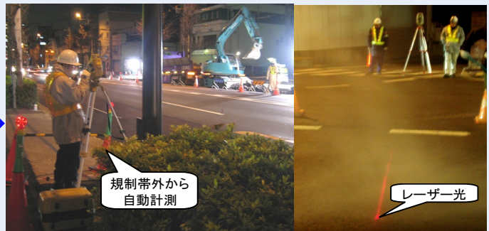
TSによる出来形計測
