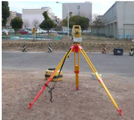
写真－9 TSの設置
