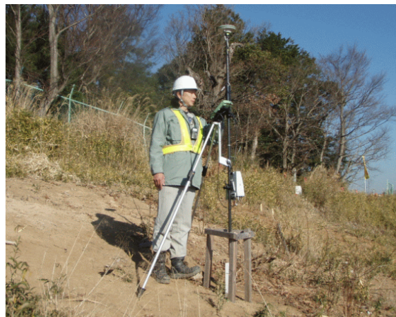
写真-8 ローカライゼーション測量状況
