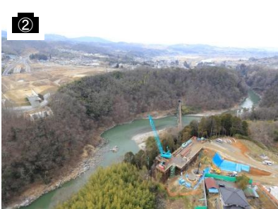
天龍峡大橋左岸側
