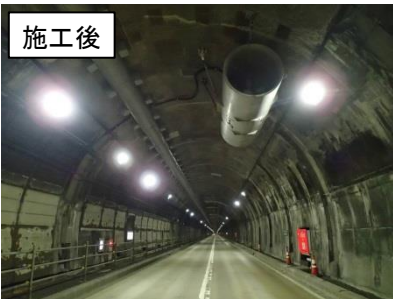
鳥居トンネル天井板撤去
