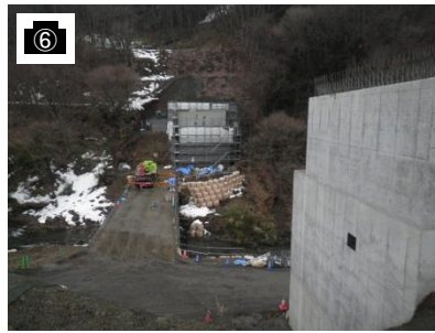
2号橋 A1橋台
