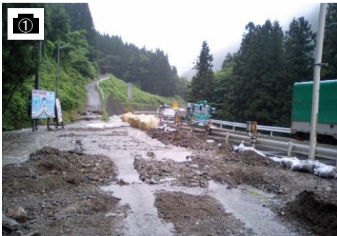
豪雨による土石流災害
