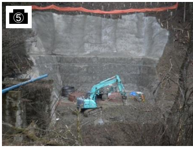
1号橋 A2橋台
