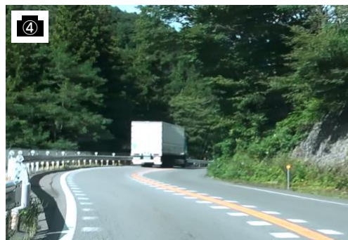
線形不良箇所
