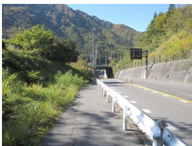
棧地区歩道設置(上松町)
