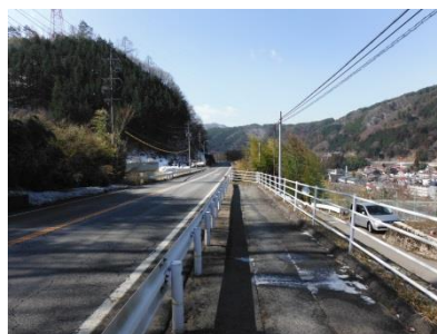
越畑地区歩道設置(木曾町)
