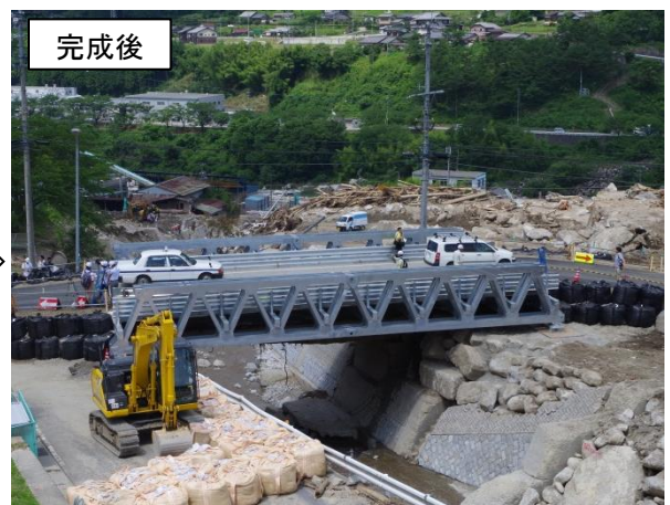
南木曾町県道264号梨子沢橋 応急組立橋の設置状況
