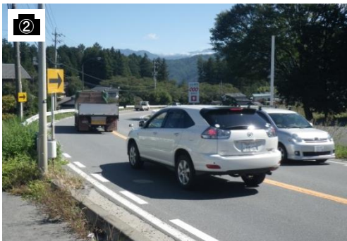
線形不良箇所
