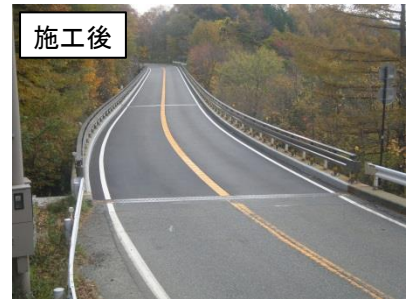
橋梁修繕(床版)
