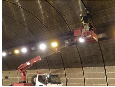
トンネル点検
