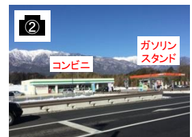
開通区間の状況②
