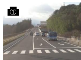
開通区間の状況①
