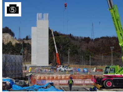
4号橋 P11橋脚
