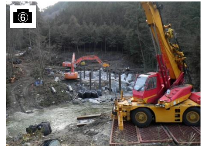
二日洞工事用道路
