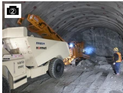
② 長野県側調査坑(坑内)
