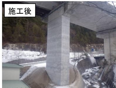
橋梁耐震補強
