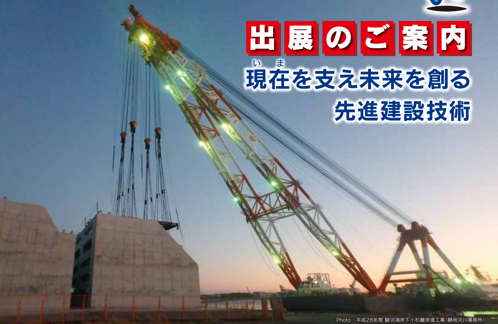
Photo：平成28年度 駿河海岸下小杉離岸堤工事(静岡河川事務所)
