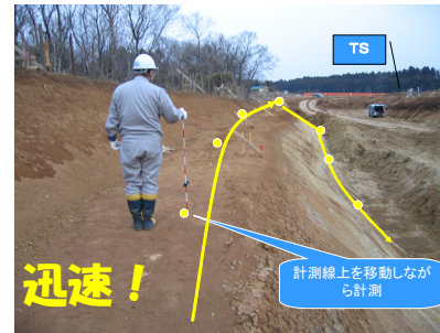
【TS出来形管理】計測ポイントを移動しながら計測
