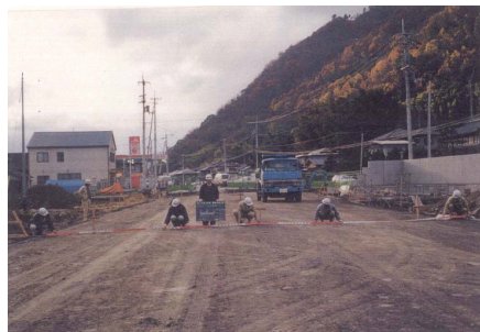
【従来方法】断面毎に計測・移動
