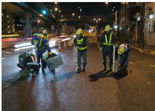
(a) 水系計測状況（写真管理も実施）
