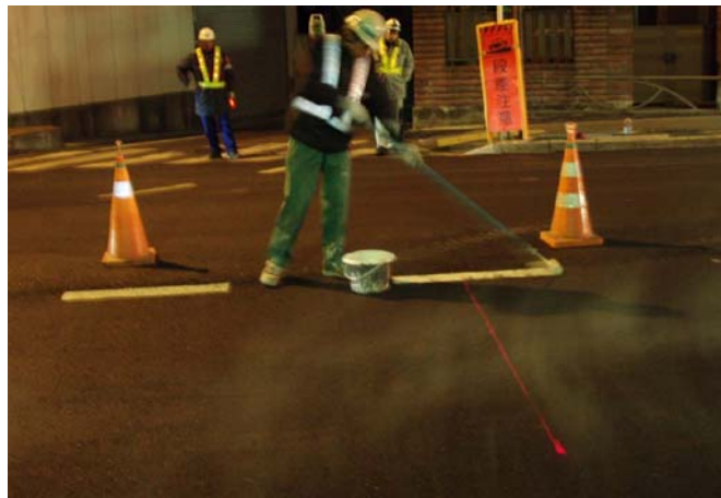
(b) ノンプリズム方式の計測レーザ走査状況
