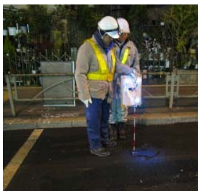
(a) 本線内へのプリズム設置状況
