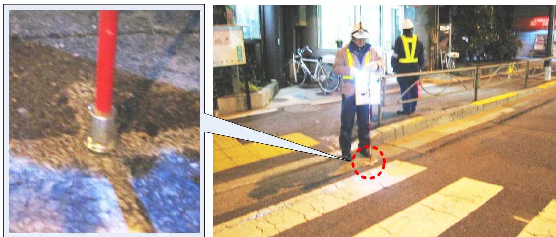
写真－ 3 凹凸がある路面へのプリズム設置例
