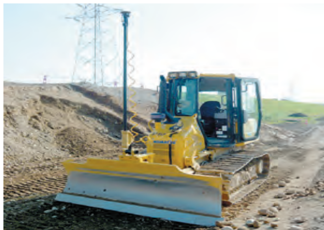
☆3D マシコントロールシステムブルドーザー
