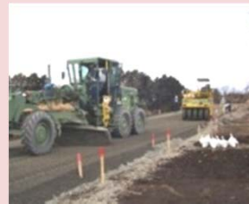
丁張りに合わせて施工
