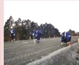
検測と施工を繰り返して整形
