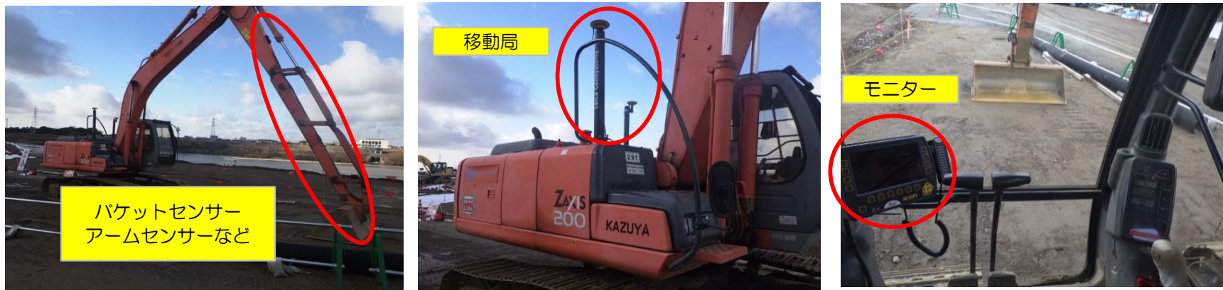
MGバックホウシステム 設置状況
