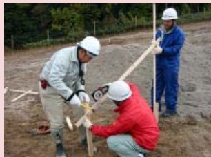
設計図に合わせて丁張り設置
