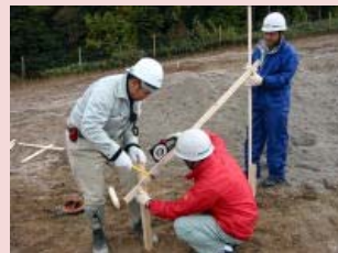
設計図に合わせて丁張り設置
