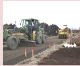
丁張りに合わせて施工
