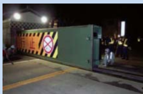
写真② 勝山陸閘
