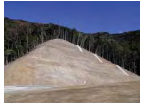
①掘削完了写真
