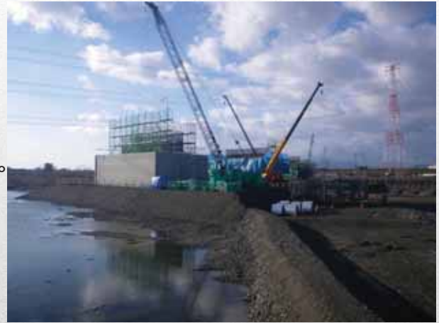
O-P6 施工状況
