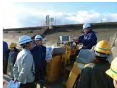
GNSS締固め管理
