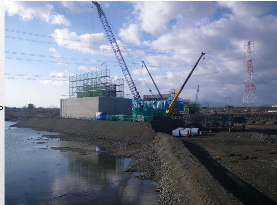
O-P6 施工状況
