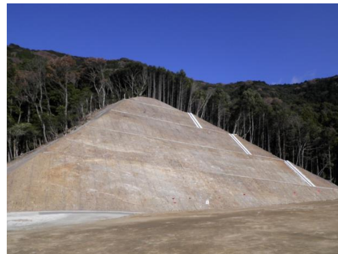
①掘削完了写真
