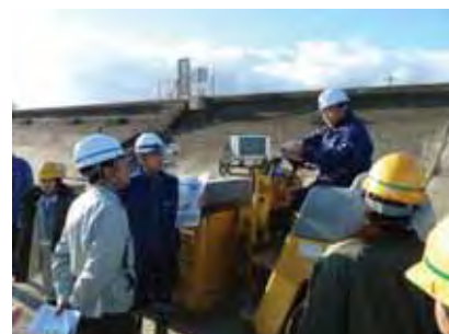
GNSS締固め管理
