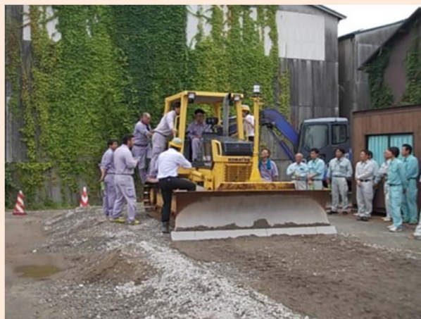
情報化施工セミナー (株)前田製作所
