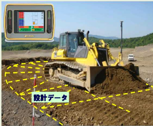
▲マシンコントロールブルドーザ技術
