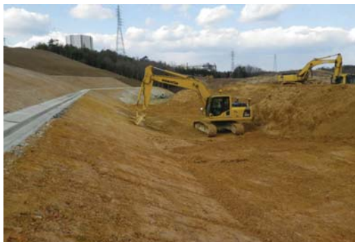
盛土部法面整形施工状況
