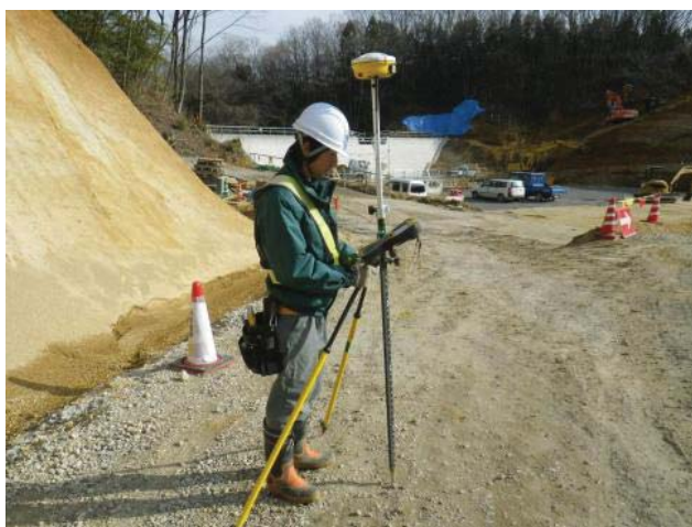
GNSS(GPS)を使用した測量作業状況
