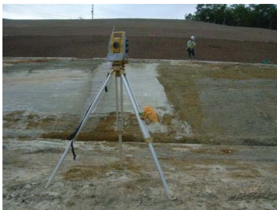
TS出来形実施状況
