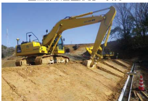
盛土部法面整形施工状況
