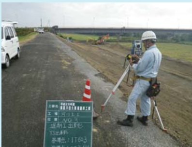
掘削工 TS出来形
