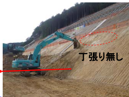
3Dバックホウ施工事例
