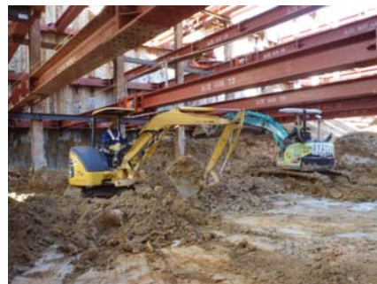
2Dバックホウ施工事例
