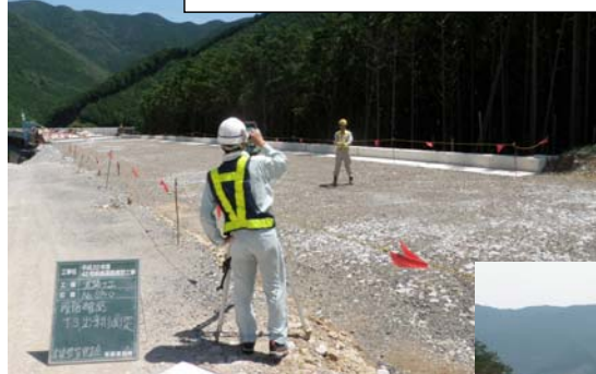
路体盛土工 TS出来形
