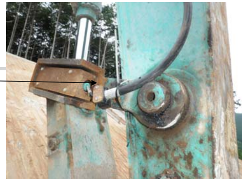
飛び石等による破損
