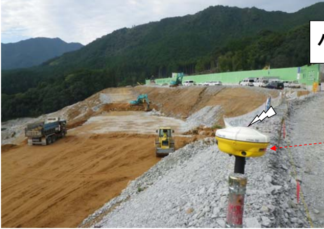
盛土部のGNSS(E.L+50m付近) ブルドーザ、振動ローラへ
