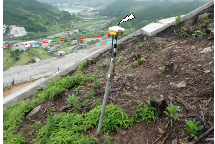
切土部のGNSS(E.L+100m付近) バックホウへ
