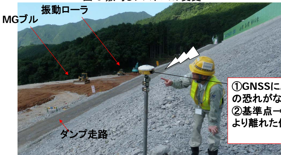
図-3 敷均しシステムの変更
