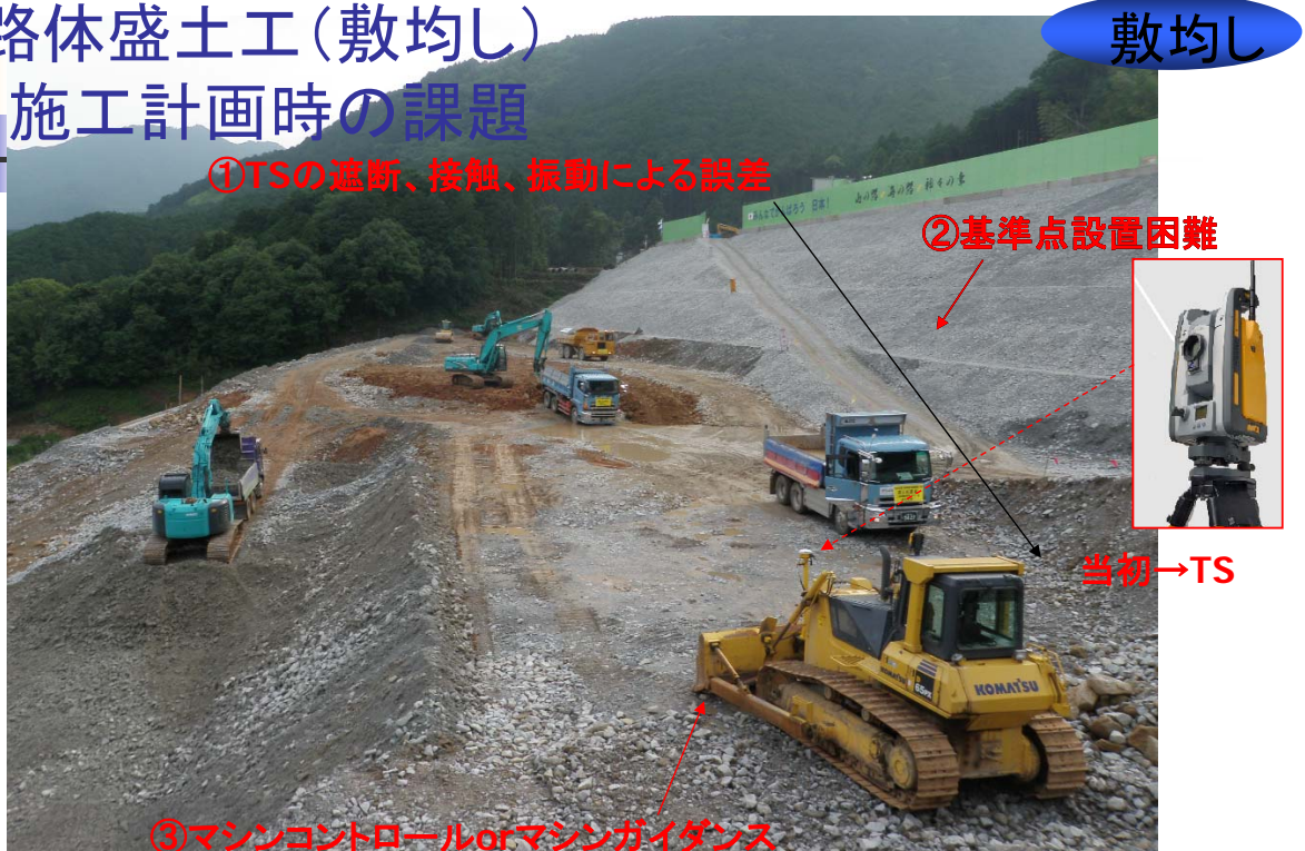
写真-1 路体盛土施工状況
