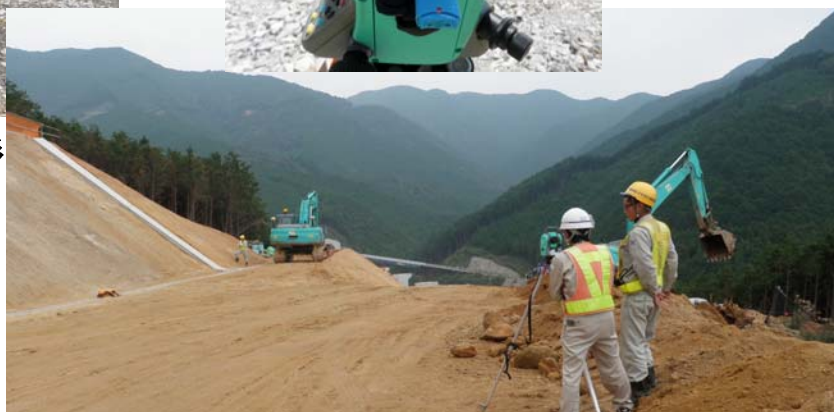
掘削工 TS出来形
