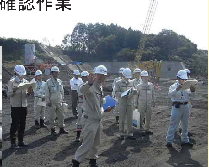
現場確認作業
