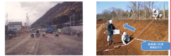
【従来方法】断面毎に計測・移動
