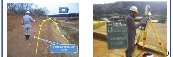
【TS出来形管理】計測ポイントを移動しながら計測
