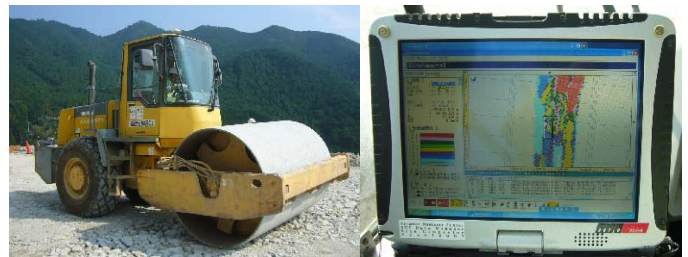
写真-4 GNSS 締め固め管理
