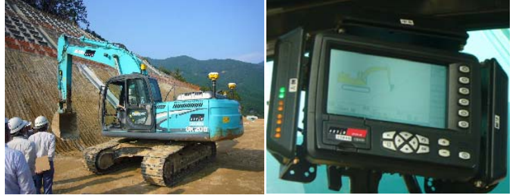
写真-1 MG バックホウ（左）、コントロールボックス（右）
