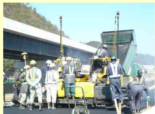
Asフィニッシャ(高さ管理) による舗設状況
