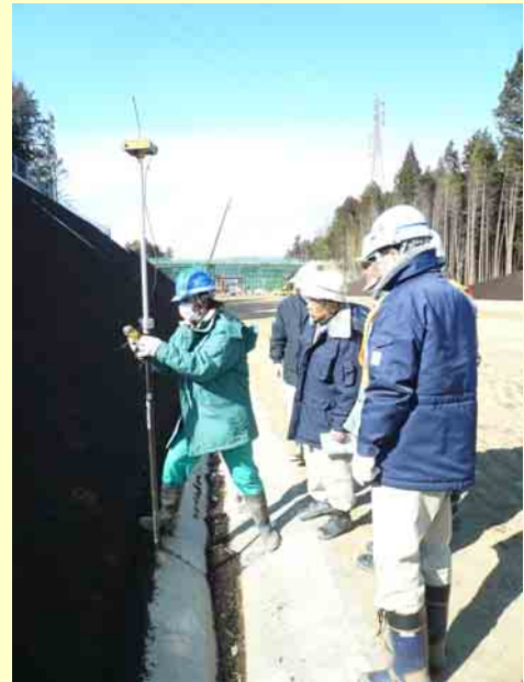
GNSSによる基準点設置状況
