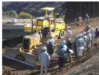
MGブルドーザとGNSS締固め管理技術
