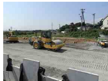
ローラによる締固め回数管理
