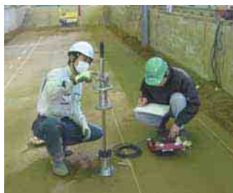
小型FWD試験状況
