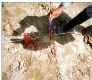
幅員計測状況(巻尺)
