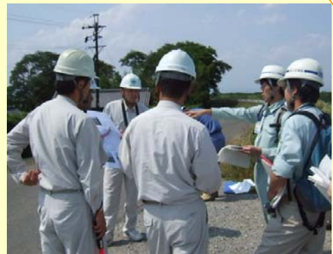
(木曾上) 瑞穂築堤護岸工事
