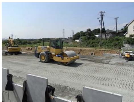
ローラによる締固め回数管理
