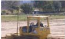
④ 3次元マシンコントロールシステム (ブルドーザー・グレーダー)
