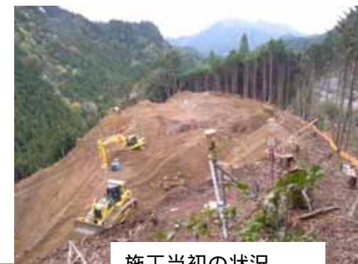
施工当初の状況
