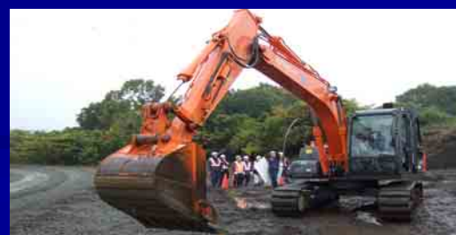
建設ICT体験(国交大研修状況)
