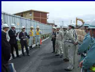
(沼津)ハツ溝高架橋仁田下部工事
