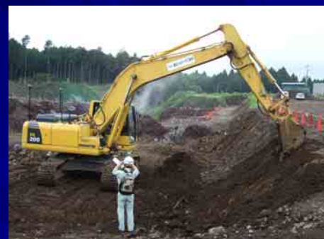
“ICTバックホウによる土作業”
