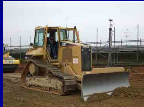
“マシンコントロールによる土作業”
