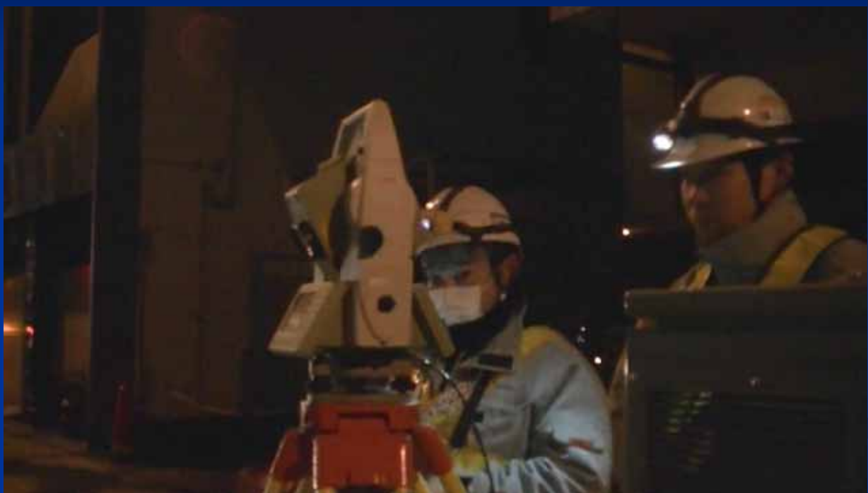
TSによる出来形計測実施状況（平成21年度試行工事）
