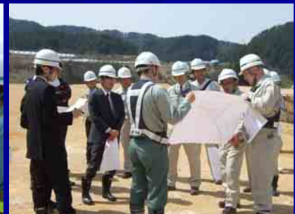
(高山)上切道路建設工事
