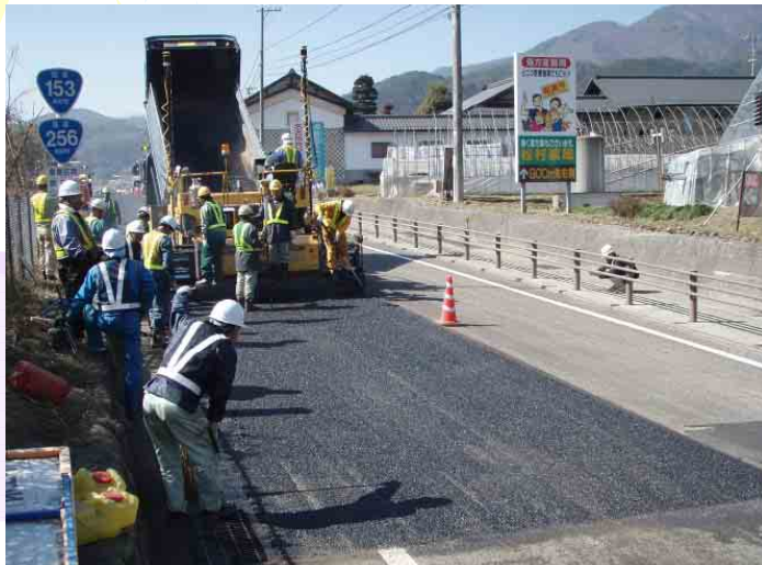
ICT施工（アスファルト舗装時の作業状況）
