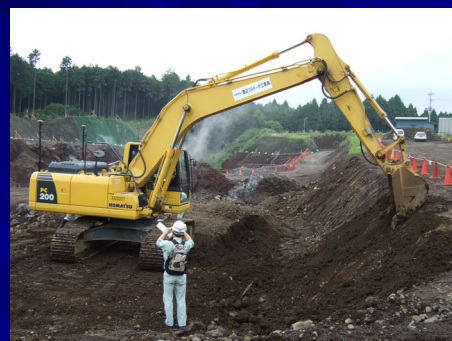
“ICTバックホウによる土作業”
