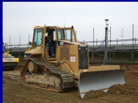
“マシンコントロールによる土作業”
