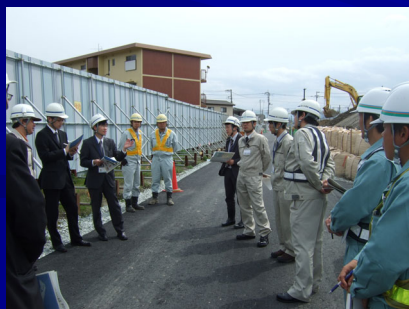
(沼津)ハツ溝高架橋仁田下部工事
