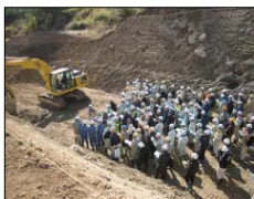
情報化施工見学会(中部地方整備局:建設ICT導入研究会HPより)
