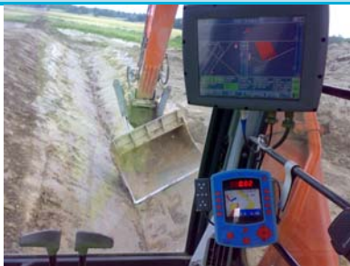
スウェーデンの道路工事の例
