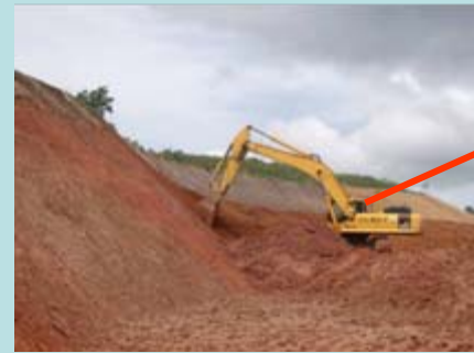
丁張り・補助作業不要
