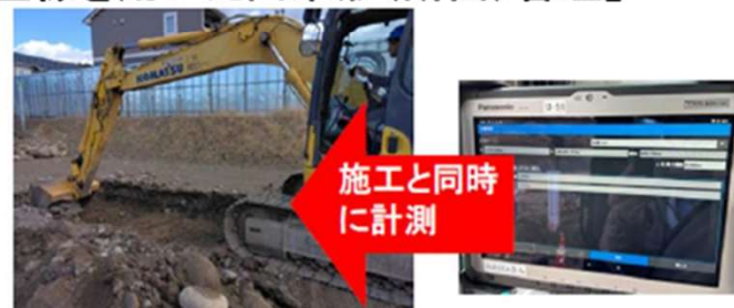
②3D-MG施工 + ②刃先による計測
