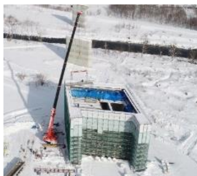
プレキャスト部材の活用
