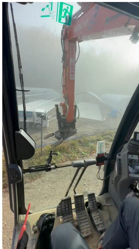
小基礎の引き抜き
