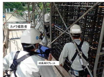
①臨場(受注者)の状況
