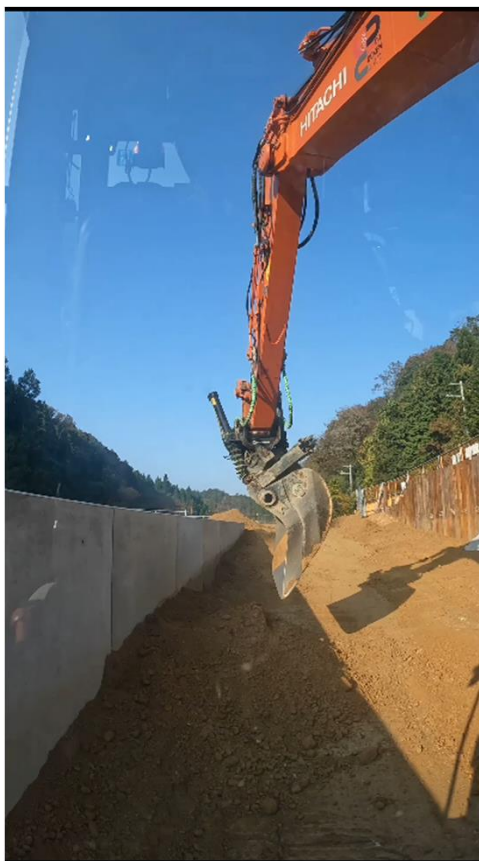
構造物際の施工
