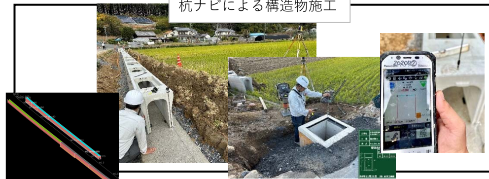
杭ナビによる構造物施工
