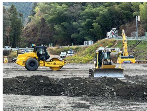
無人ブルドーザ自動敷均し及び無人振動ローラ自動転圧
