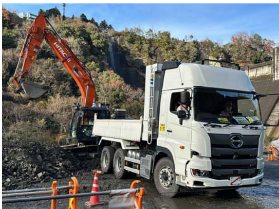
ダンプトラック自動運転及び無人バックホウ自動掘削・積込
