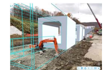
掘削作業時にARと比較
