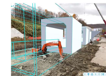
掘削作業時にARと比較
