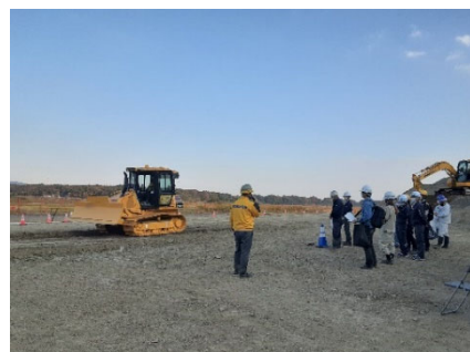
【実演】MCブルドーザによる地形測量
