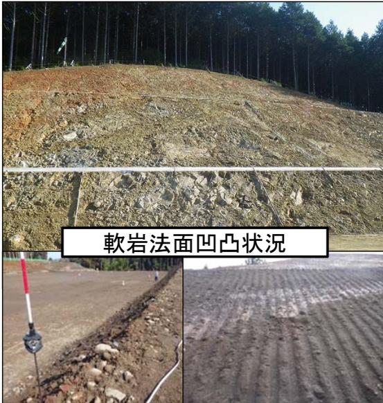
○ 軟岩等の掘削現場(従来の断面管理実施)で面的な出来形の実態を把握し管理基準値を設定。
