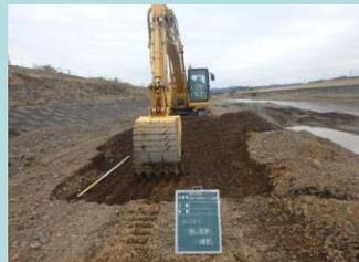
精度検証の後、河床掘削をする。流水で形状変化しても施工履歴は変化がない。
