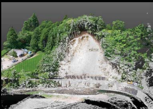
被災後の3次元点群データ
