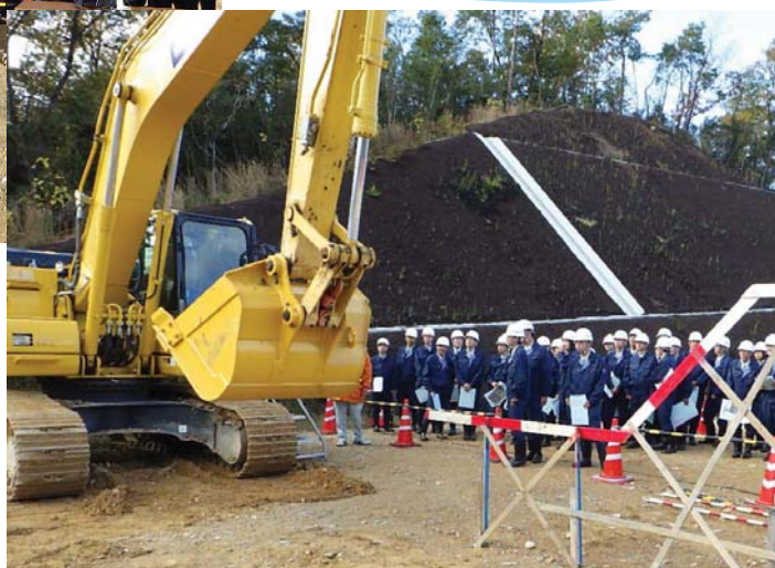
工業高校生を対象とした現場見学会状況 (左上) UAVのデモ飛行 (右下) MCパック材によるICT建機のデモ操作
