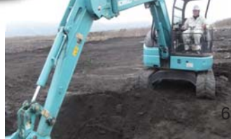
正確な精度で掘削ができるICT建設機械に驚き!
