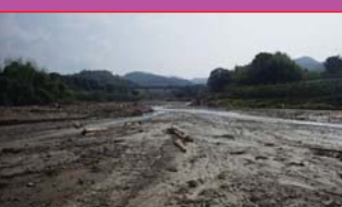
ため池が決壊し、大量の土砂、流木が流出
