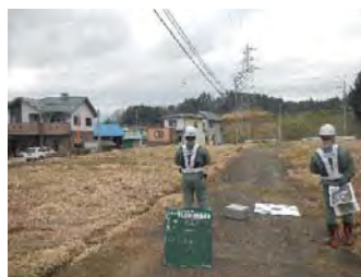
UAVによる 起工測量
