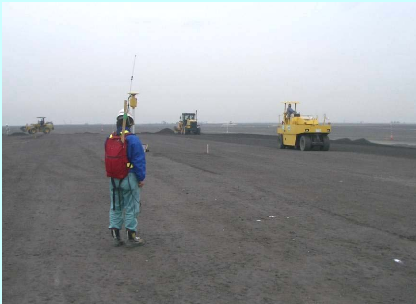
検測作業者との接触減
