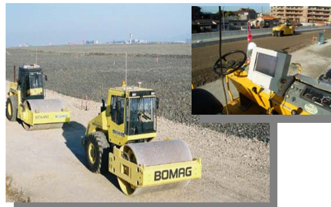
締固め転圧システム
