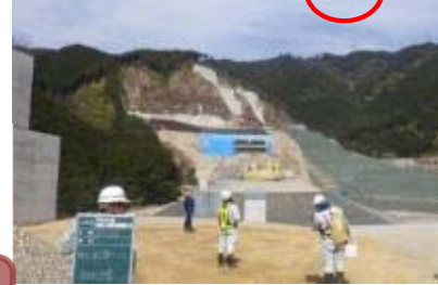
UAVによる測量
