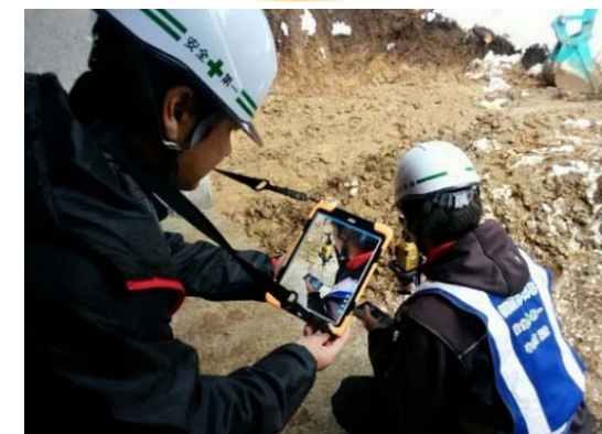
現場の状況を映像データ等により事務所に報告
