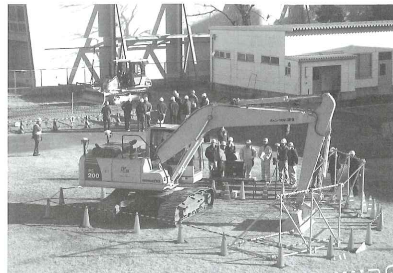
情報化施工機械の仕組みの説明や実機による施工モニター体験の様子
