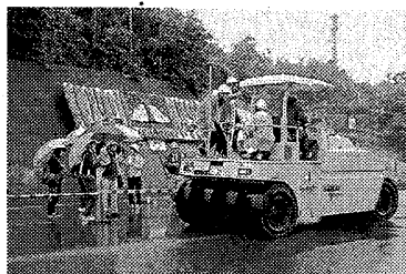
情報化施工の実習
